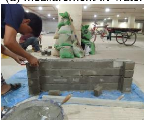
(d) making of brickwall
